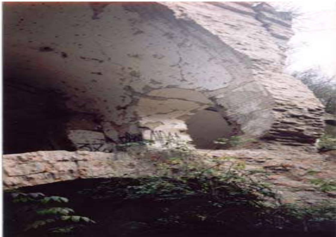
Рис. 2. Тараканівський форт: сучасний стан споруди. Аркові склепіння та перекриття 2,3,4 .
