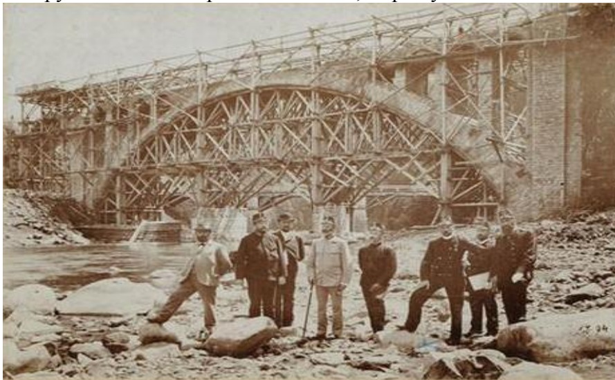
Рис.4. Будівництво моста-віадука у Яремче.
