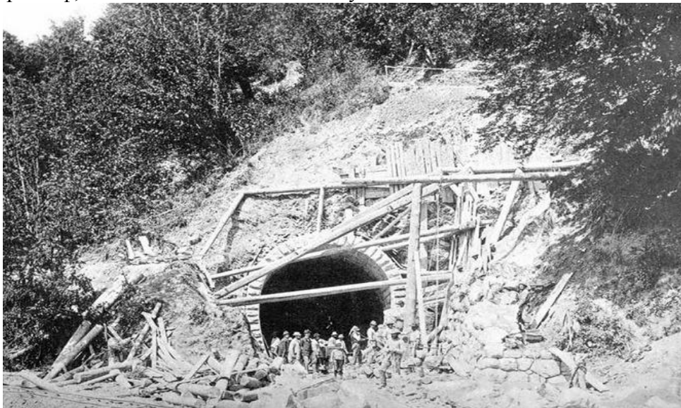
Рис.5. Будівництво тунелю на залізничній гілці 1896.
