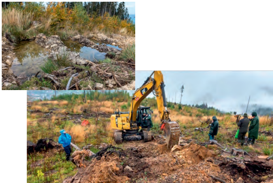
Рис. 9.9. Рекультивація лісових доріг та волоків після виконання лісосічних робіт у Чеській Республіці (фото з сайту www.aqua-inova.com )
