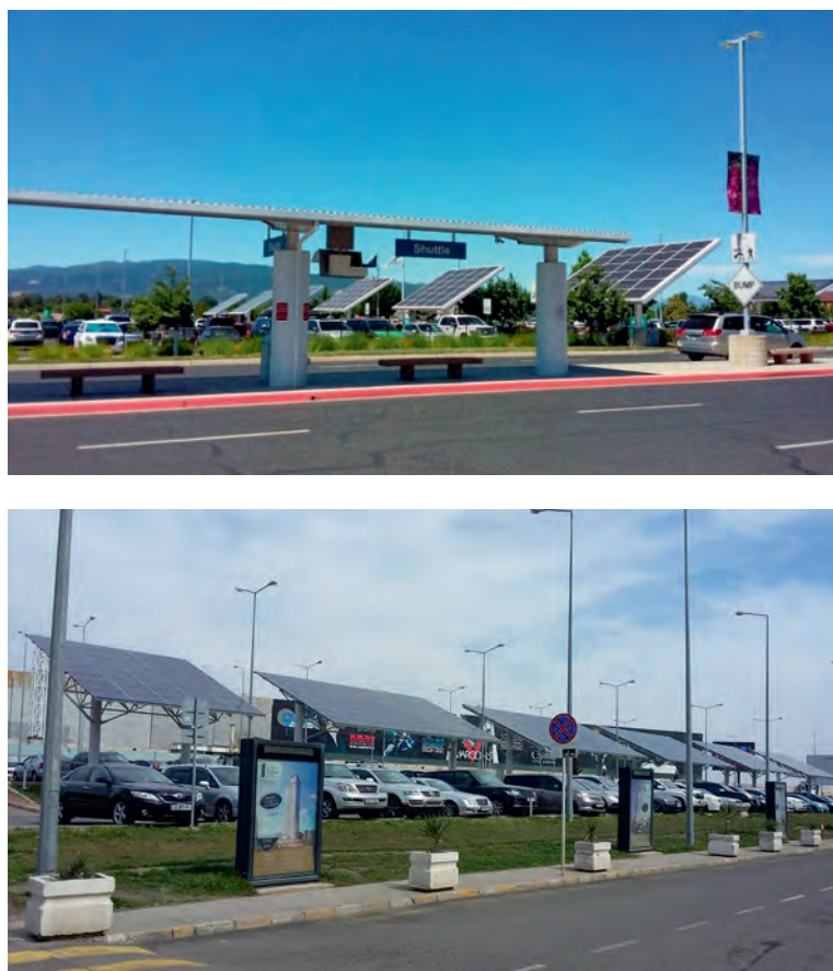
Рис. 9.6. Створення затінку та генерація електроенергії в аеропортах м. Медфорд, США та м. Тбілісі, Грузія (фото автора)
