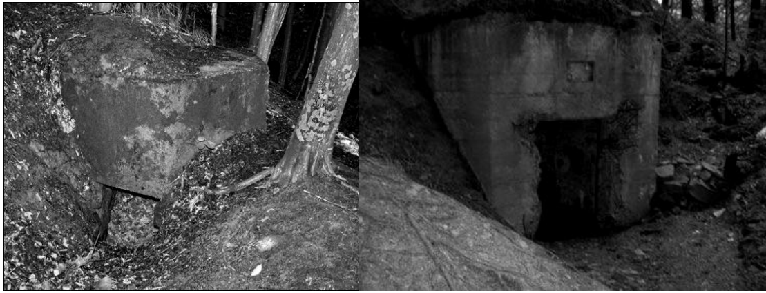
Рис.5. Одномісні залізобетонні вогняні точки з шестигранним ковпаком
