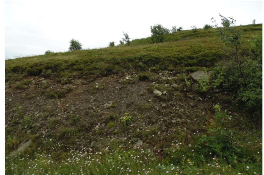
Рис. 2.4.2. Приклад зсувонебезпечної ділянки на території Полонини Руна на підрізаному схилі вздовж дороги.
