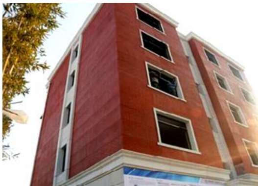
Рис.7. П'ятиповерховий будинок, надрукований на 3D-принтері компанії WinSun (Китай)
